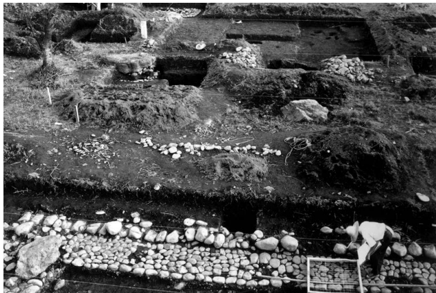
金堂の調査 昭和31年（1956）
