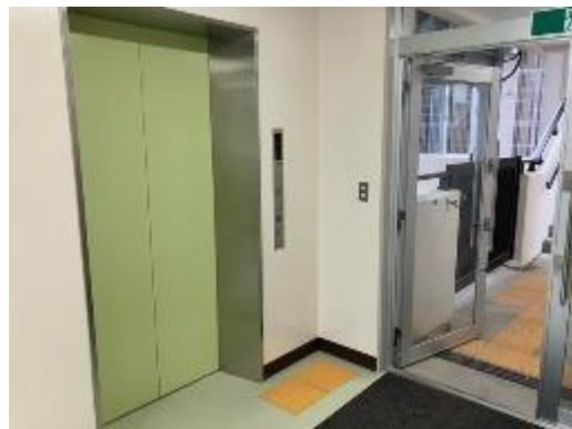
④エレベーターの設置
