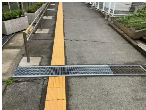
②排水溝の蓋を目の細かいものへ交換
