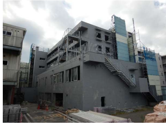
上屋解体前（外壁塗材除去後）
