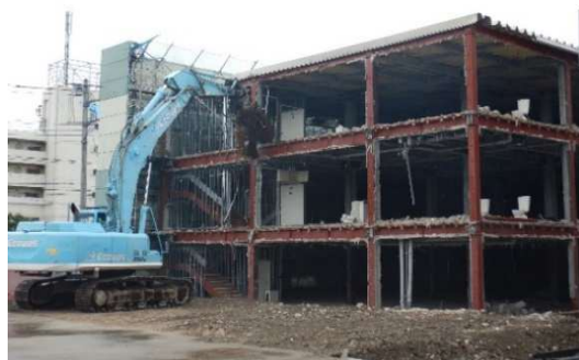
外壁 ALC パネル撤去後
