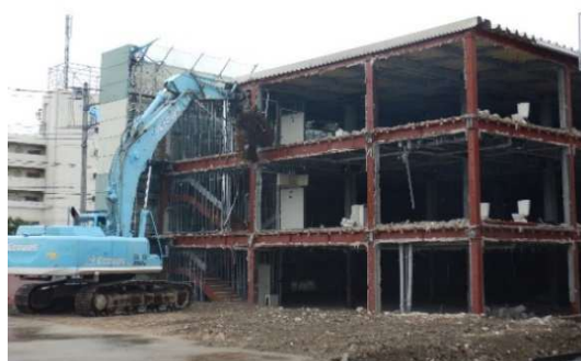
外壁 ALC パネル撤去後 10月15日
