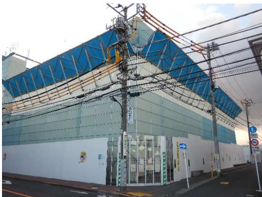
防音パネル設置後（都道 222 号線沿いより）
