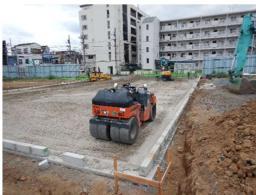
路盤施工状況 令和8年9月1日
