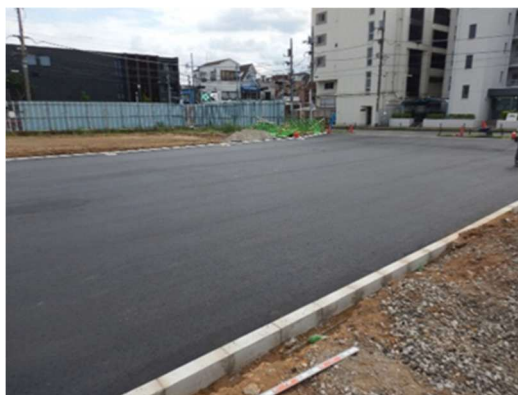
舗装整備完了 令和8年9月2日
