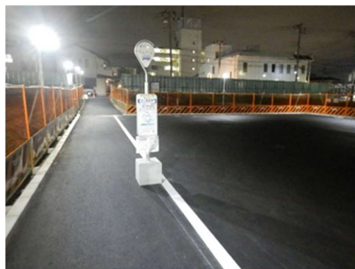
時刻表看板移設完了 令和8年9月14日
